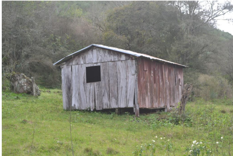
Figura 31. Edificação sem moradores observada junto à área de campo (Lat. -29.444697°; Long. - 54.077762°).
