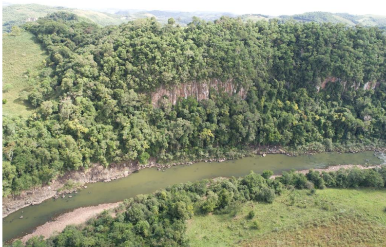
Figura 46. Trecho com forte declividade na margem esquerda (Lat. -29.436347°; Long. - 54.064965°).
