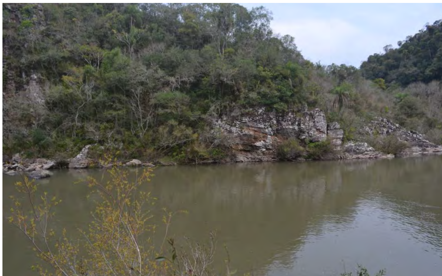
Figura 36. Margem onde está sendo implementada a saída da casa de força da PCH Salto do Guassupi (Lat. -29.405733°; Long. -54.021370°).
