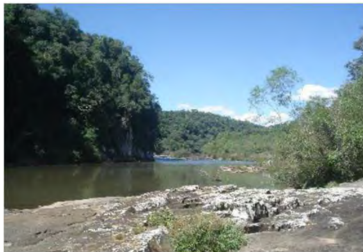
Figura 17. Vista de Afloramento Rochoso (Lajeado) e ao fundo paredão rochoso encontrado na região próxima a PCH Cachoeira Cinco Veados, junto ao final de seu reservatório.
